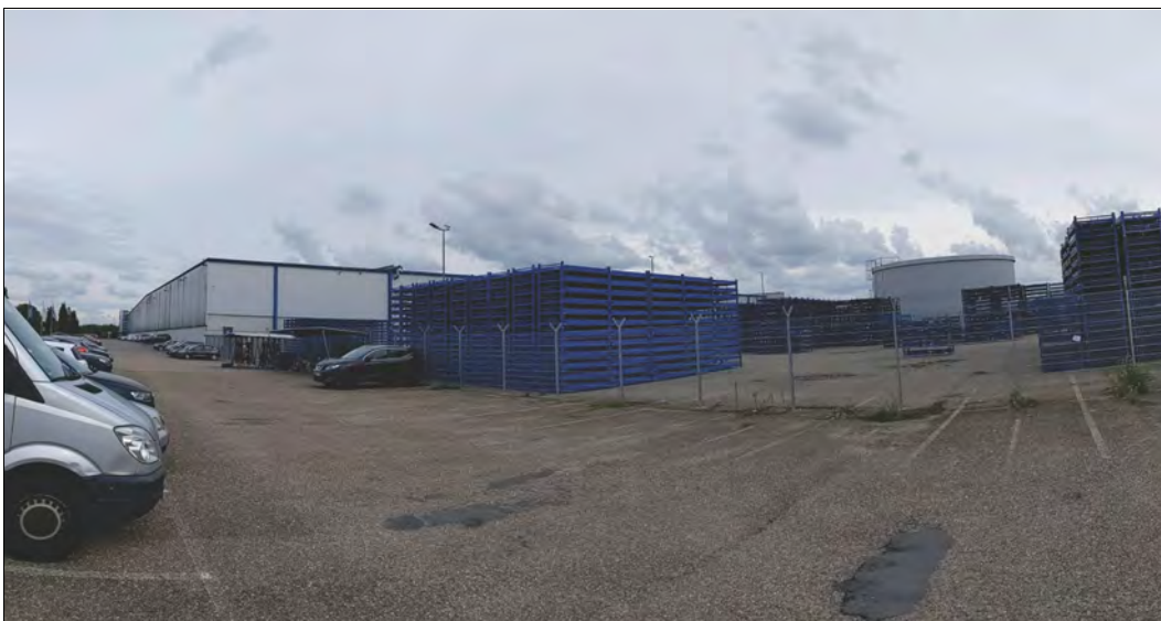
Abb. 2: Messpunkt 1: Mitarbeiterparkplatz vor Außenlager (Blickrichtung Süden)
